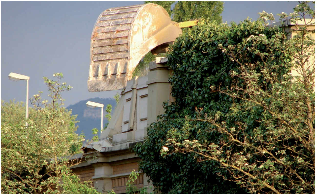
Die Schaufel des Abrissbaggers reißt die Fassade des Baus Rt 102 ein, der ehemaligen Weberei von Ulrich Gminder aus den 1880er Jahren.
