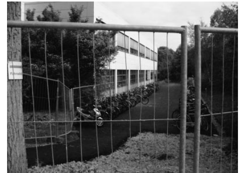
Fahrradstellplatz neben dem Bau 142. Direkt neben an wird das Drehtor 7 installiert. Dessen Verlegung wurde notwendig durch den verstärkten LKW-Verkehr Richtung Baustelle der 200 mm Fabrik.
